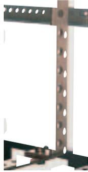
Acoplamiento entre la barra de tierra vertical y horizontal.
