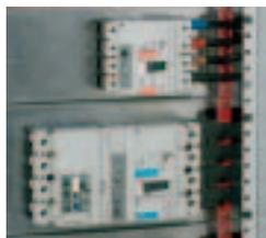
Conjunto de montaje para interruptores automáticos de caja moldeada tipo Record Plus
